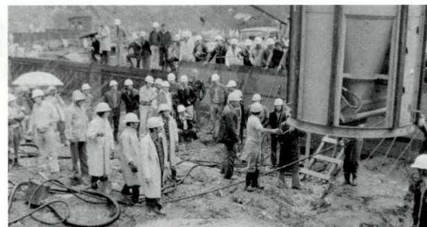
O primeiro lançamento de concreto foi no dia 11 de outubro de 1977.
