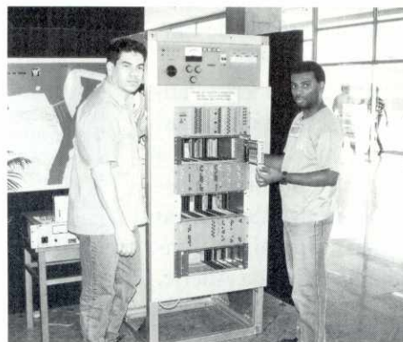
Técnicos Adolfo Ayala Quiñones e José Nascimento, com painel de ensaios para módulos eletrônicos do sistema de excitação das unidades geradoras, desenvolvido pela SMME.DT.
