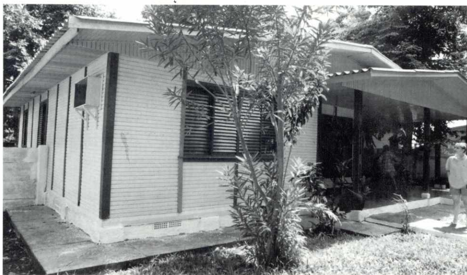
Problemas estruturais nas casas estão sendo solucionados com o trabalho de reforma.
