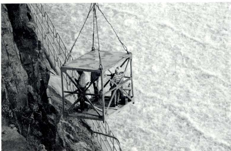
A gaiola é o meio para os técnicos se aproximarem da parede de rocha.
