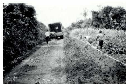
Um total de 10 mil metros de tubos levará a água até as moradias da Reserva.
