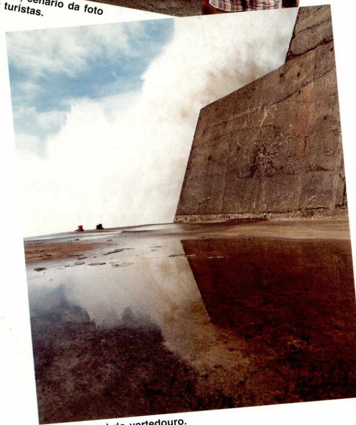
Parede lateral do vertedouro.
