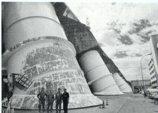
Parte da equipe que faz os serviços de proteção dos condutos: Jurandir, Acosta, Nuñez e Torres
