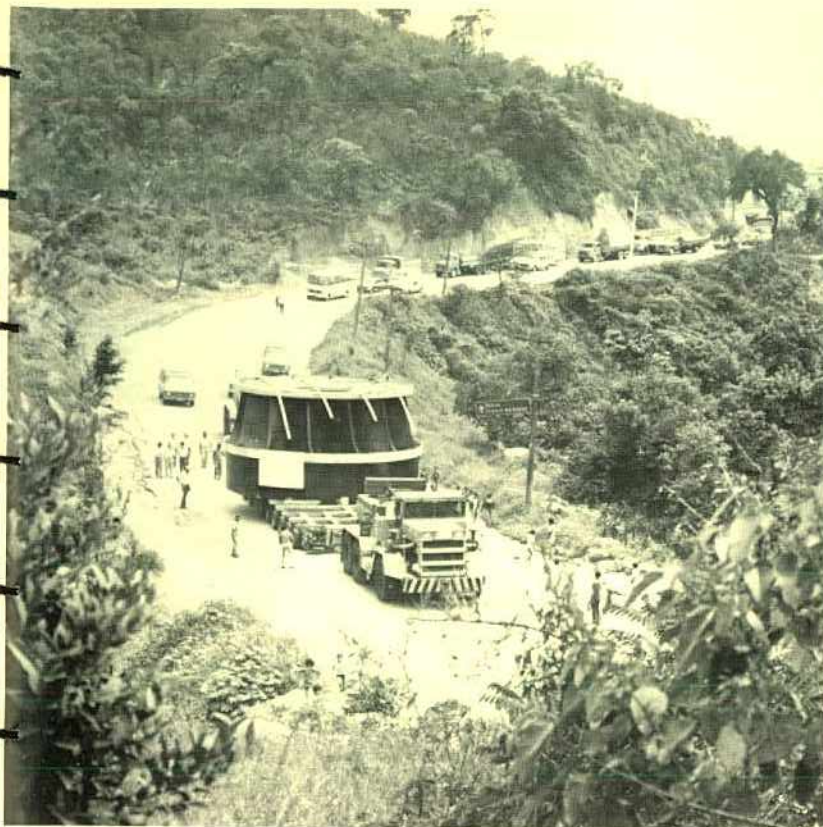
O transporte da primeira turbina interrompia o tráfego nas principais vias de ligação no Paraná
