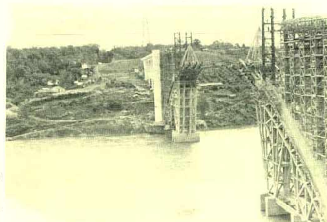
Ponte da Amizade em construção
