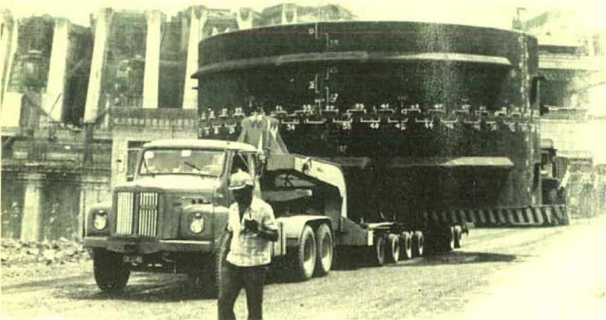
Técnico da Itaipu acompanha o transporte de um rotor já dentro da usina.
