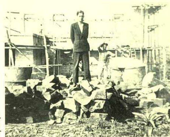
O mestre de obra Erico Pruner na frente do pavilhão da Companhia Independente (ao fundo operários cortam pedra e rebocam paredes)
