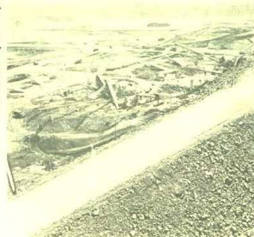
Usinas de britagem, instaladas dentro da usina de Itaipu que forneceram pedra britada para a concretagem.
