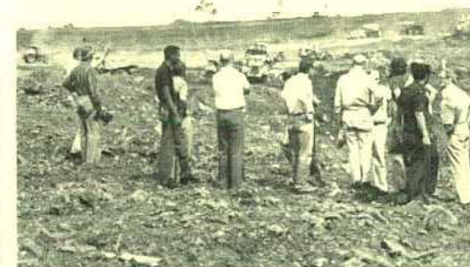
Técnicos da Itaipu observam o início das obras de terraplanagem na Usina de Itaipu em 1976
