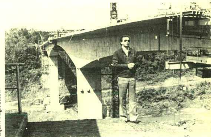
Etapa final da construção.
