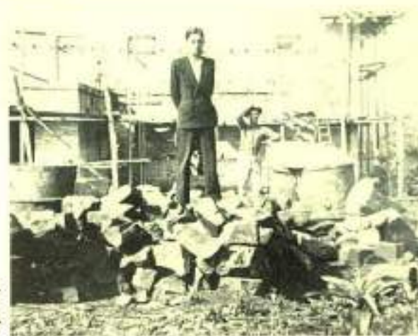
O mestre de obra Erico Primer na frente do pavilhão da Companhia Independente (ao fundo operários cortam pedra e rebocam paredes)
