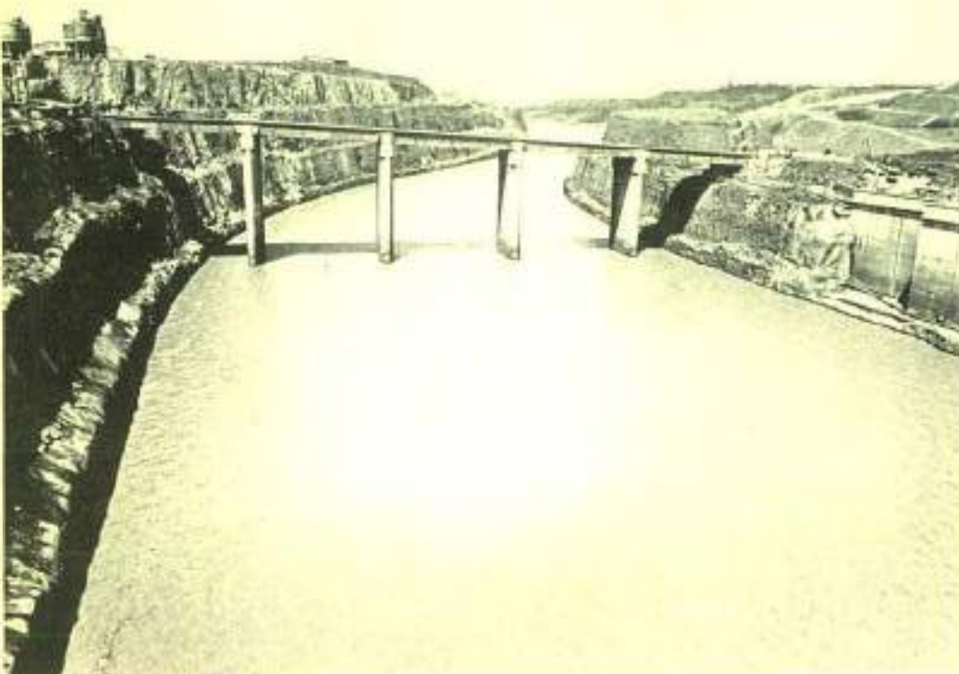
O canal de desvio do rio Paraná que possibilitou a construção da usina.
