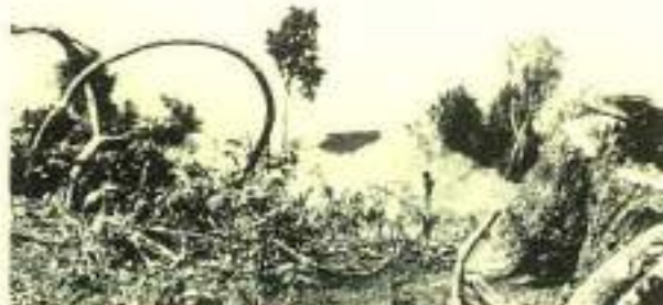
Início das obras de terraplenagem na área escolhida para a construção
