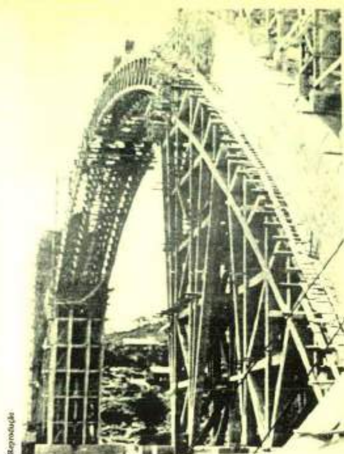
Arco da Ponte com vão livre de 290 m.
