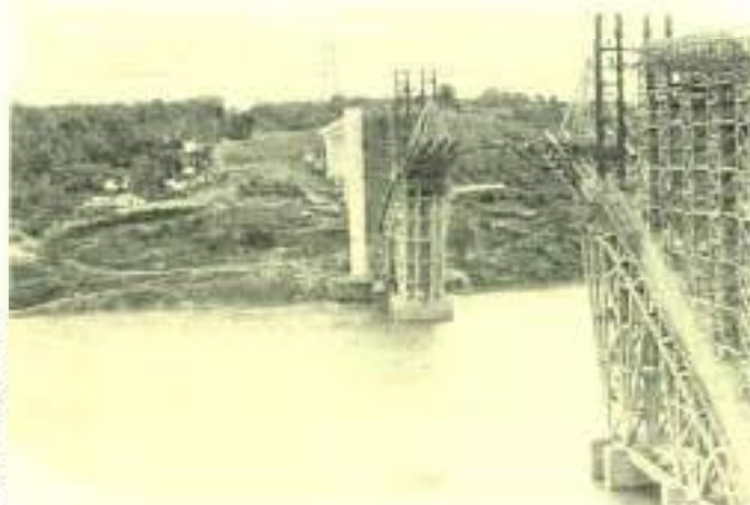
Ponte da Amizade em construção
