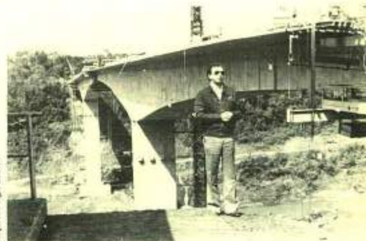
Etapa final da construção.
