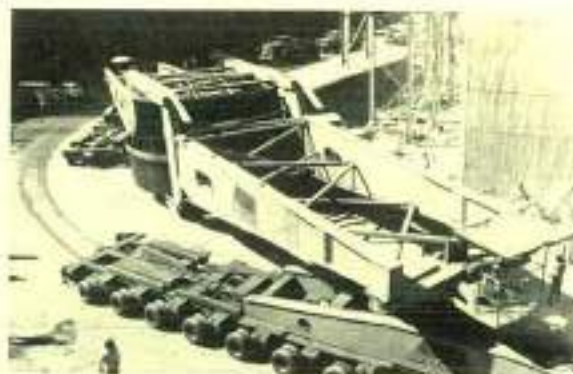
Um dos 18 rotores sendo descarregado na margem esquerda da usina.
