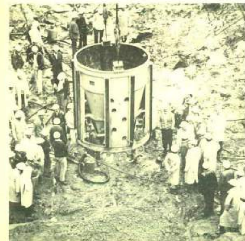
Descida da primeira caçamba de concreto na usina de Itaipu, em setembro de 1977.
