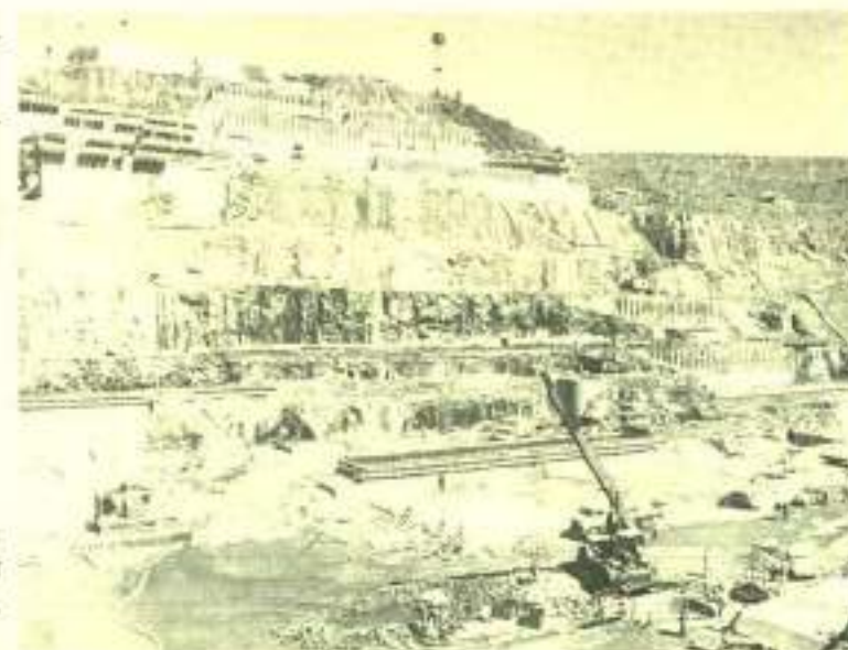
Início da concretagem da usina de Itaipu.
