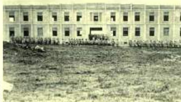
Soldados e comando da Companhia Independente posam em frente do primeiro pavilhão da Companhia Independente de Fronteira (atual 34º BIMtz) concluído no final dos anos 30
