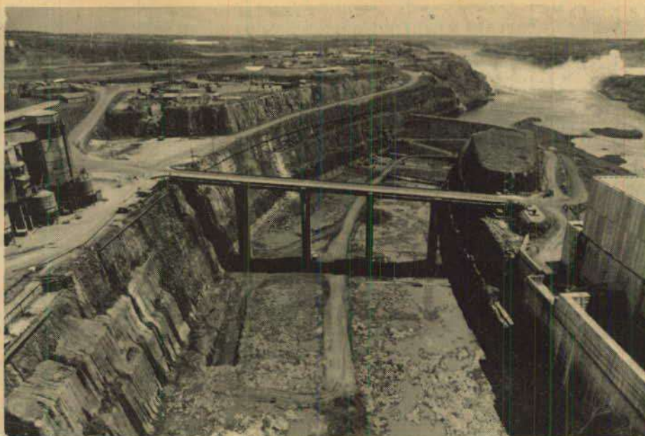
Iniciada em janeiro, a construção da Casa de Força do Canal de Desvio é a grande tarefa do momento
