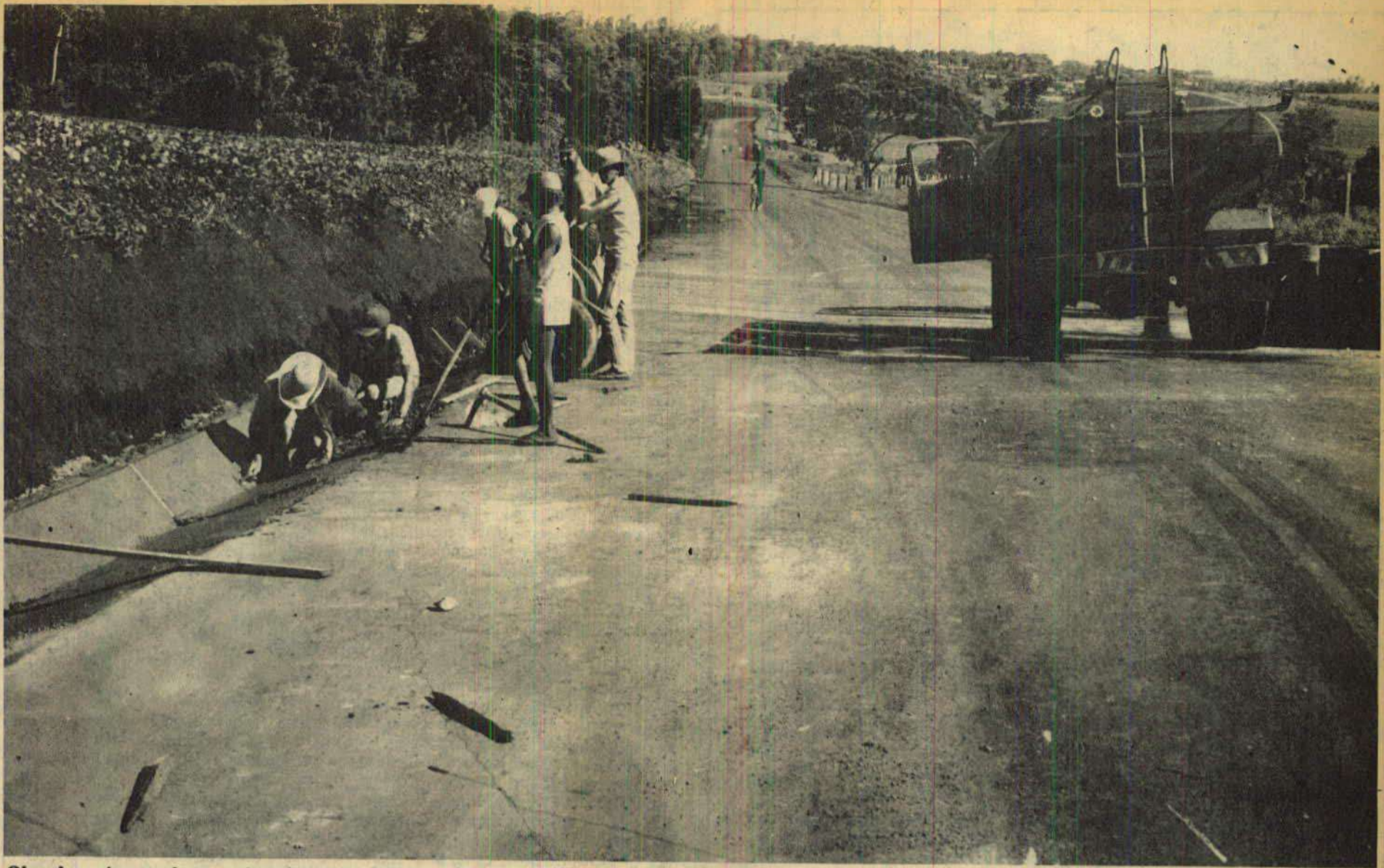
Obra de pavimento do acesso à praia artificial de Foz do Iguaçu sendo executada pela Itaipu Binacional
