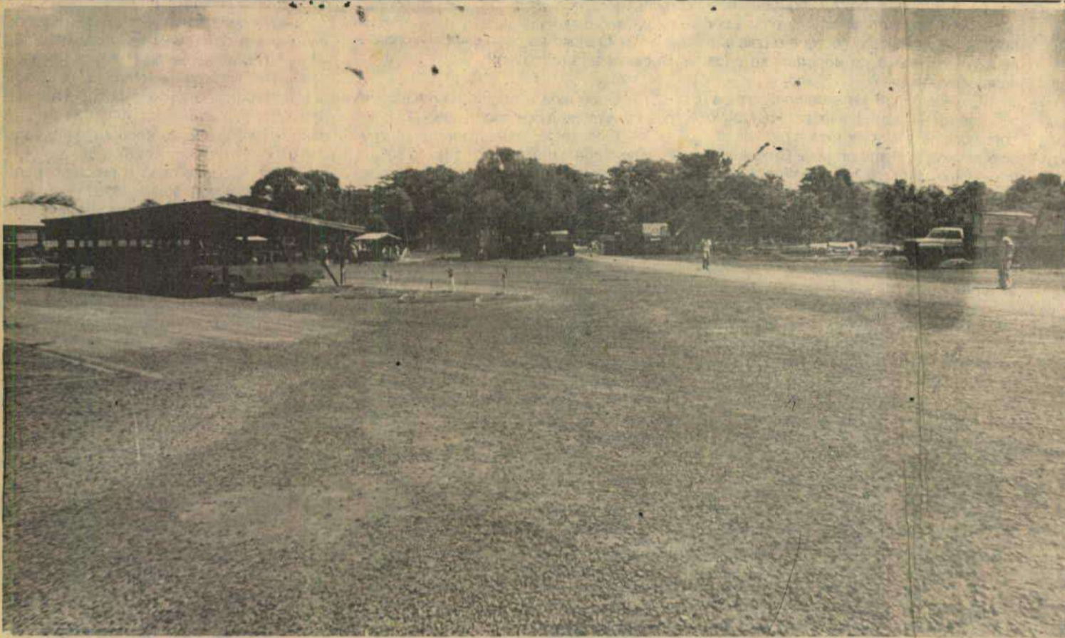
Canteiro de obras do Centro Náutico Recreativo de Guaíra, que está sendo construído pela Itaipu Binacional
