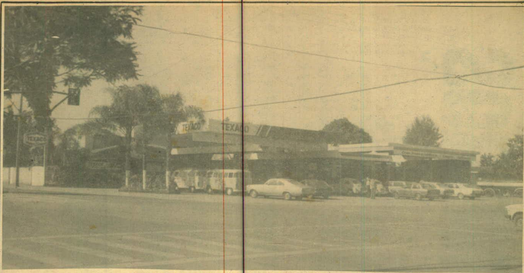
Sede do Posto Internacional. Agora totalmente remodelada.
